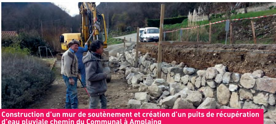
Construction d'un mur de soutènement et création d'un puits de récupération d'eau pluviale chemin du Communal à Amplaing
