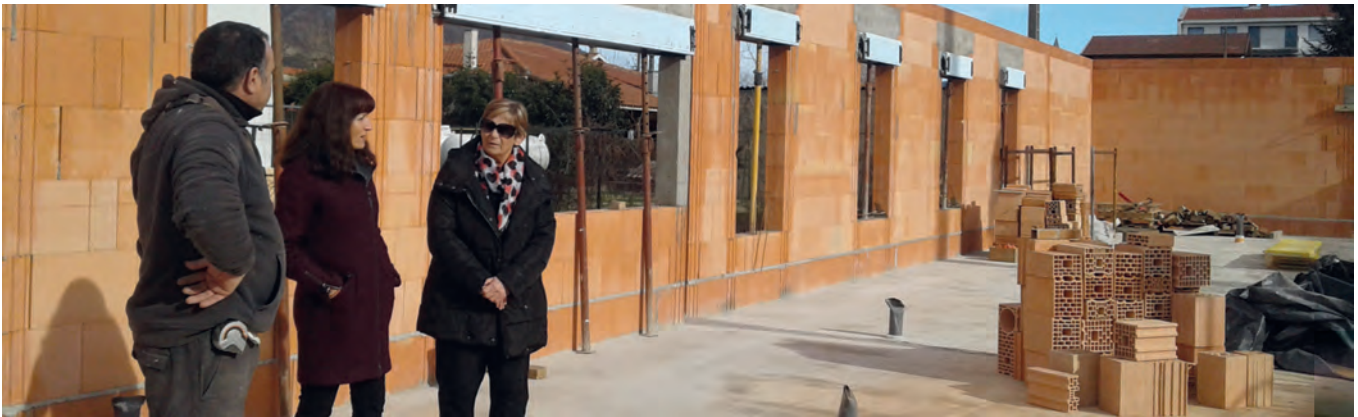
La construction de la maison médicale progresse.
