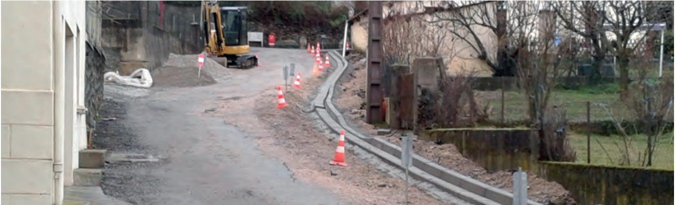
Les travaux d'aménagement de la rue Ambroise Croizat sont en cours de réalisation.
