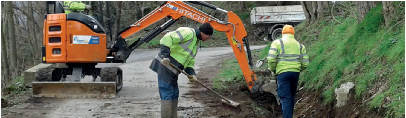
Afin de permettre l'écoulement des eaux de surface et éviter que la chaussée ne soit inondée, les agents techniques municipaux ont creusé les fossés en bordure de la route conduisant à Jarnat.
