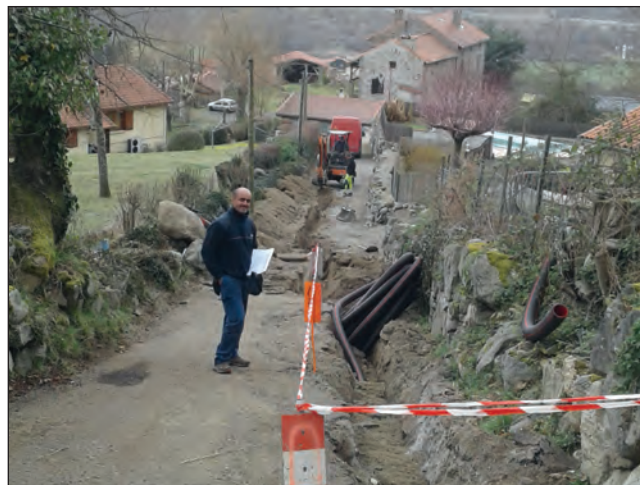
Alimentation en électricité du réservoir d'eau situé chemin La Caze à Mercus
