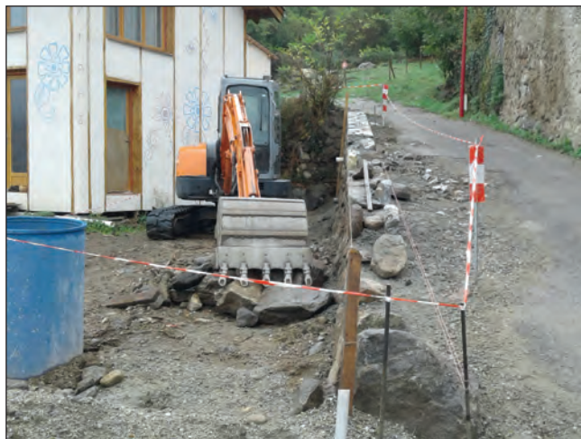
Construction d'un mur de soutènement de route à Jarnat
