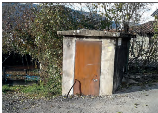
Le SMDEA a procédé à la démolition des anciens chateaux d'eau alimentant Jarnat, Croquié et Garrabet
