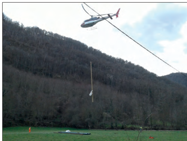
Remplacement des pylones supportant le réseau électrique qui alimente le relais TV
