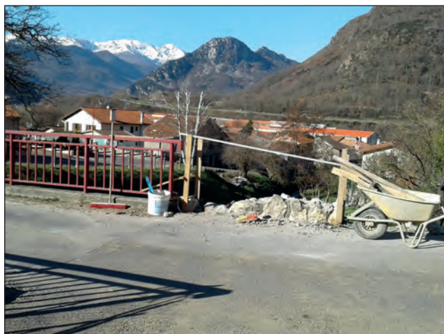
Réfection du parapet du pont situé route de Croquié
