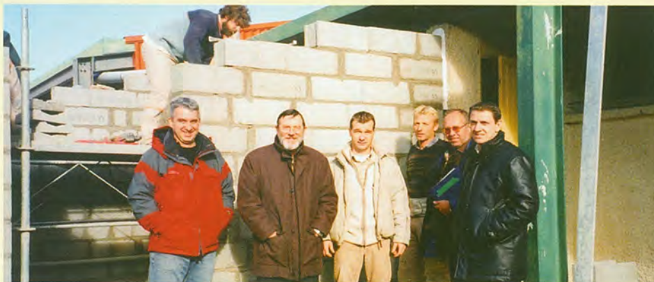
La visite du chantier de la salle polyvalente par José LORENZO et les responsables des travaux
