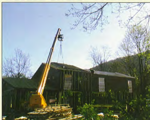
HÉBERGEMENT TOURISTIQUE : RÉSIDENCE ARIÈGE AZIMUTH DE M. ÉRIC WEYDERT À GARRABET, POSE DU TOIT DU CLUB HOUSE
