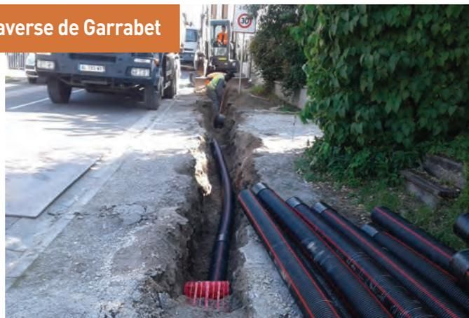
Des travaux de mise en sécurité et d'enfouissement du réseau électrique 20 000 Kva sont en cours de réalisation.
