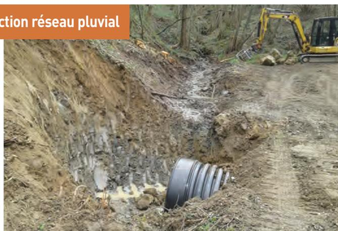
Le réseau d'évacuation d'eau pluviale en partie endommagé par les intempéries de Janvier 2022, a été réparé.
