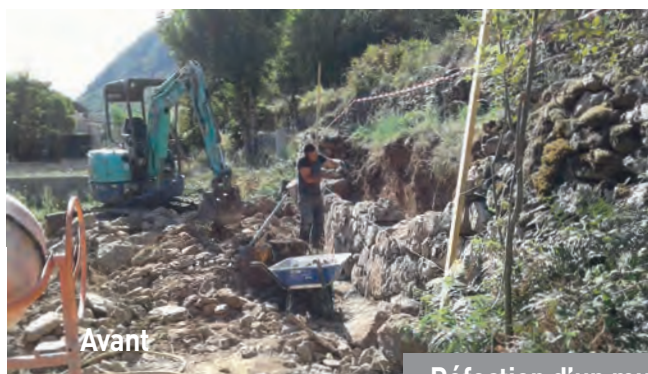
Réfection d'un mur de soutènement à Amplaing
