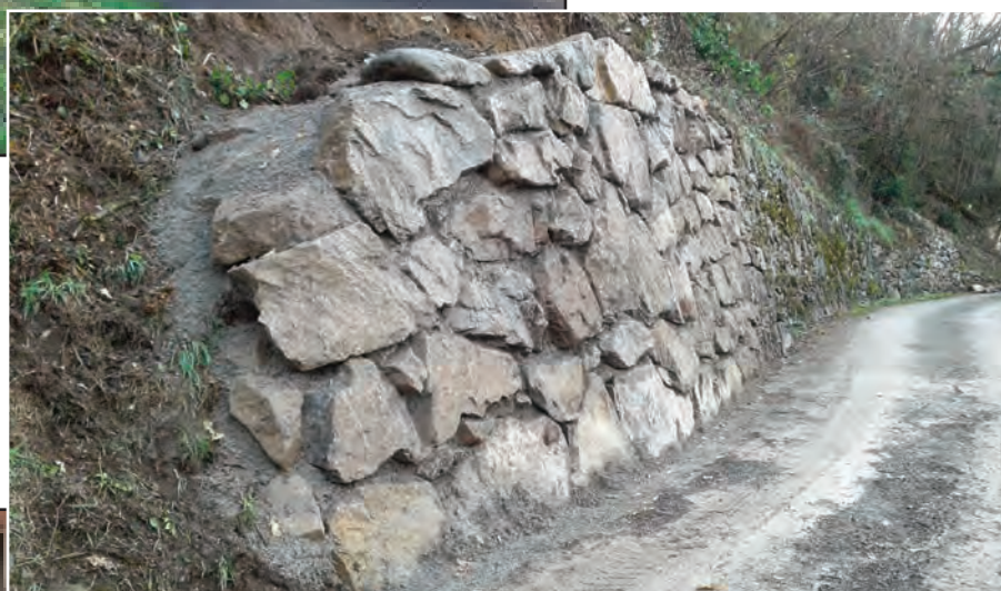
Consolidation du mur route de Jarnat →
