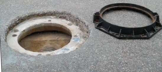
Réfection regard pluvial sur la RD 8b qui traverse Amplaing
